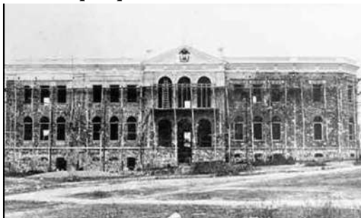
Figura 8 - Construção do grupo escolar Luiz de Albuquerque no início do século XX
