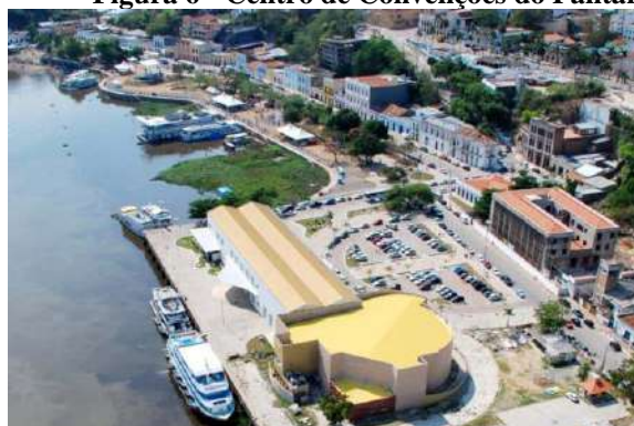
Figura 6 - Centro de Convenções do Pantanal
